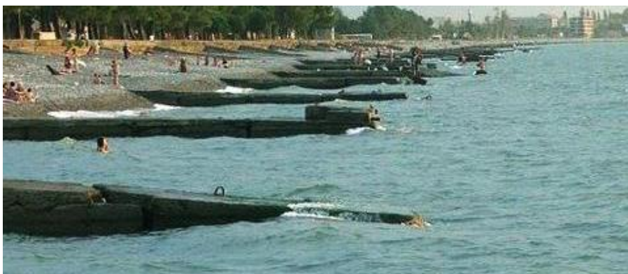
სურათი 1. რკინა-ბეტონის ნაპირსამაგრი ბუნის სერიის ნგრევა ოჩამჩირის ნაპირზე
